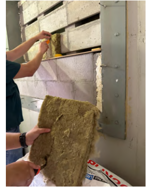
(d) Aplicação de lã de rocha nas cavidades dos elementos vazados.
